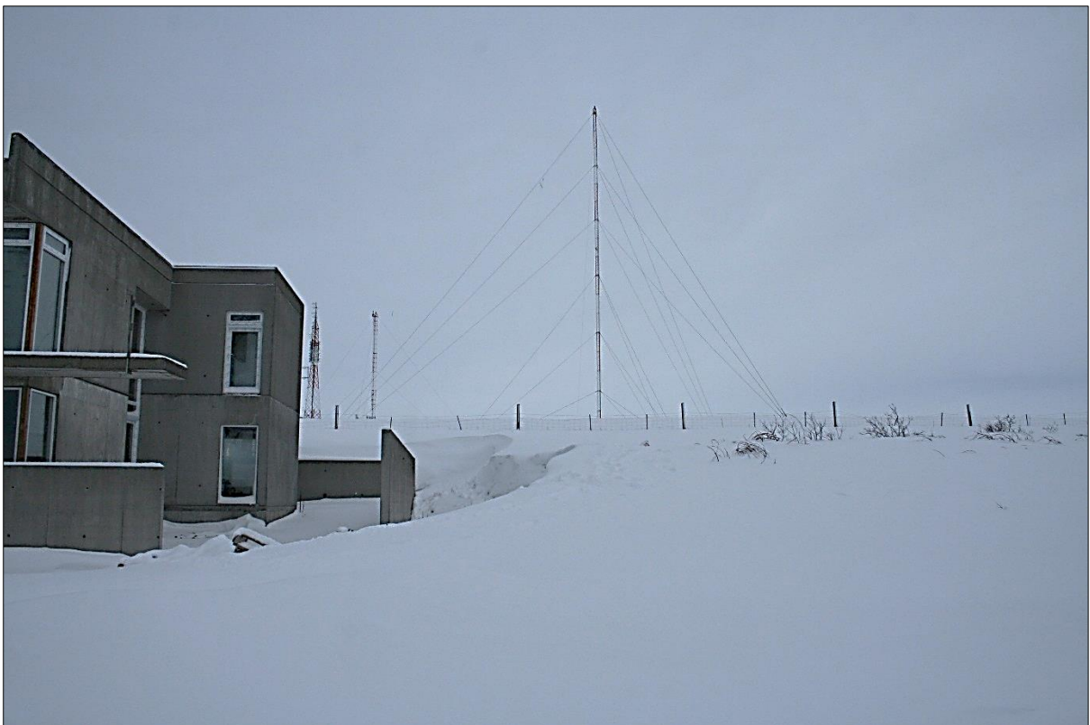
Mynd 2 Afstaða að möstrunum á Vatnsendahæð frá Kleifakór 6. Fjarlægð er um 150 m.
