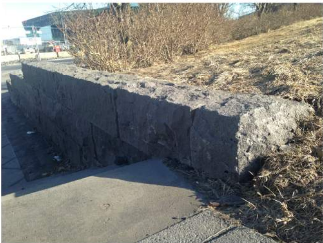
Dæmi um grágrýtishleðslu úr söguðu grágrýti með topp og sýnilegar hliðar tilhoggnar. Mynd frá vegg við Arnahól.
