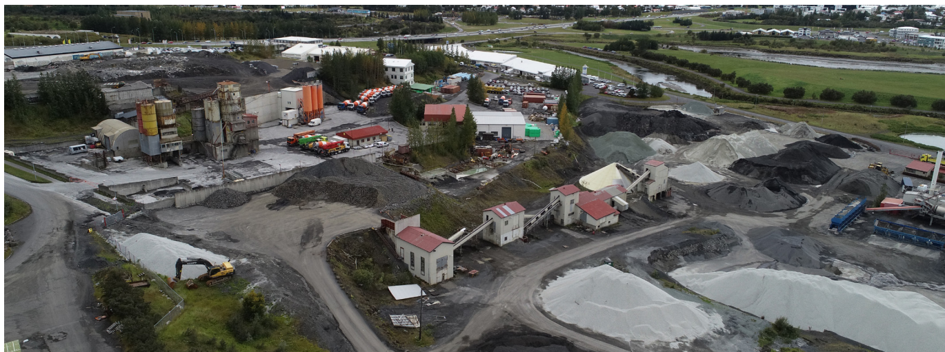
Mynd 8. Grjótmulningshús við Sævarhöfða 6-10
